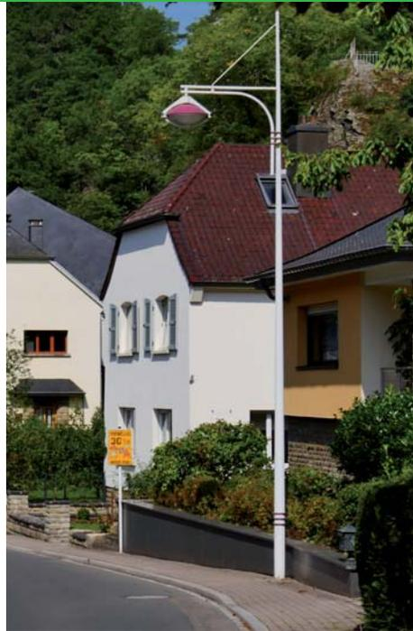
Technische Mastleuchte einfach mit Ausleger. Die Lichtpunkthöhe beträgt etwa 6,00m. Die Leuchte ist in einem weißen Farbton lackiert, der Leuchtenkopf ist rot abgesetzt.
