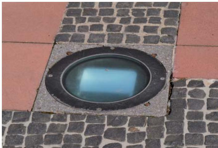
Vorh. Anstrahlung über Bodeneinbaustrahler: Sparkasse an der Grand Rue
